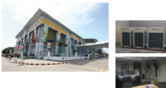
ทำระบบปรับอากาศ โรงเลี้ยว ก๊าซ Renovate ออฟฟิศ โรงเลี้ยว
