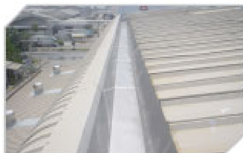
งานติดตั้งรางน้ำฝนแบบเอส
