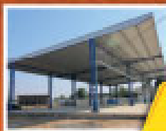
Cellular Beam แบบปกติ
