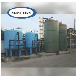
ติดตั้งระบบบำบัดน้ำ Auto Filler 30 m3/hr.
