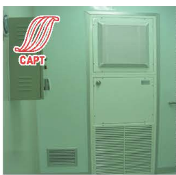
ระบบปรับอากาศ แบบแยกส่วน Clean Air Unit (CAU)
