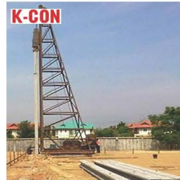
ปั้นจั่นตอกเสาเข็ม Pile Driver
