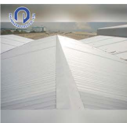
รับผลิตและติดตั้งงานหลังคา เมทัลชีท Metal Roofing Sheet Installation
