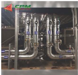
งานหุ้มฉนวน ร้อน เย็น Cold Insulation Work (Black Rubber insulation, Close Cell, PU Foam)
