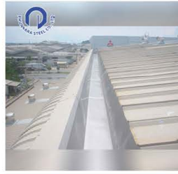
รับผลิตและติดตั้งรางน้ำสังกะสีและสแตนเลส Stainless and Galvanized Gutter Installation
