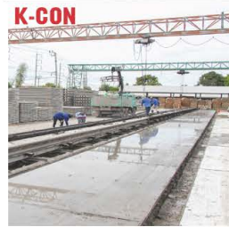
โรงงานผลิตแผ่นพื้นคอนกรีต Concrete Plank Slab Factory
